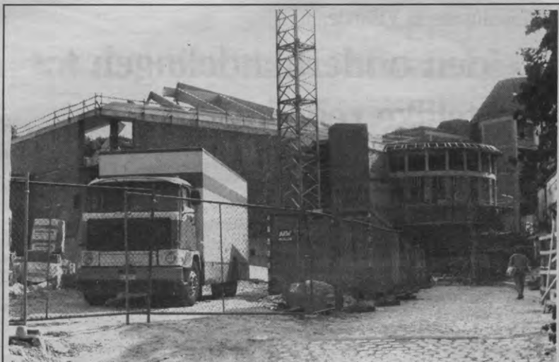
DE AULA MAXIMA, alias Aula Piet De Somer, begint stilaan vorm te krijgen. Afgelopen week werd de fraaie pyramidale dakconstructie erop geplaatst. Volgens architect Paul Van Aerschoot verloopt alles volgens plan: de ruwbouw moet klaar zijn tegen het bouwverlof (november-december) zodat men vanaf dan aan de inrichting kan werken. In oktober 1989 zou men de Aula in gebruik kunnen nemen. Het zou in elk geval een oplossing bieden voor het overbevolkingsprobleem in de faculteiten Economie en Rechten. (Foto Didier Wijnants)
