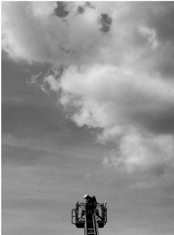
Een dakbrand zorgde voor schade in aula 200G in Heverlee.
